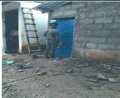
Foto 2: instalación de puerta de dirección
