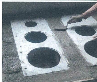
Foto 6: Instalación de polle-ton
