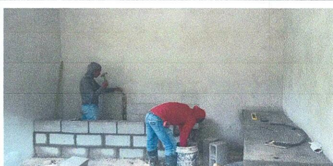
Foto 2: instalación de polle-ton
