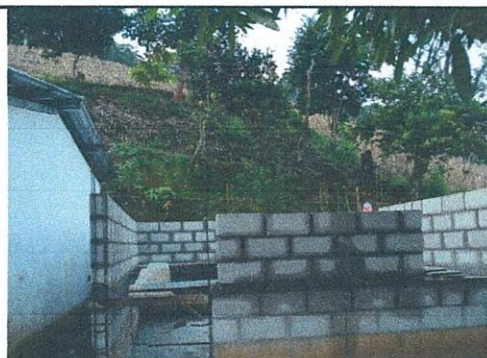
Foto 4: Levantado de paredes
